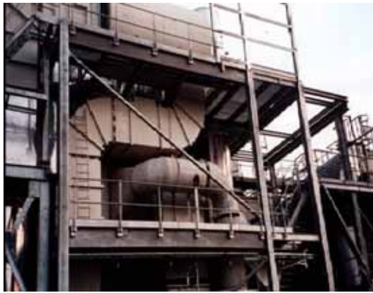
Εφαρμογές Άμεσης Καύσης. Η εγκατάσταση στην δεξιά φωτογραφία διαθέτει επιπλέον σύστημα ανάκτησης θερμότητας από τον εξερχόμενο αέρα.
